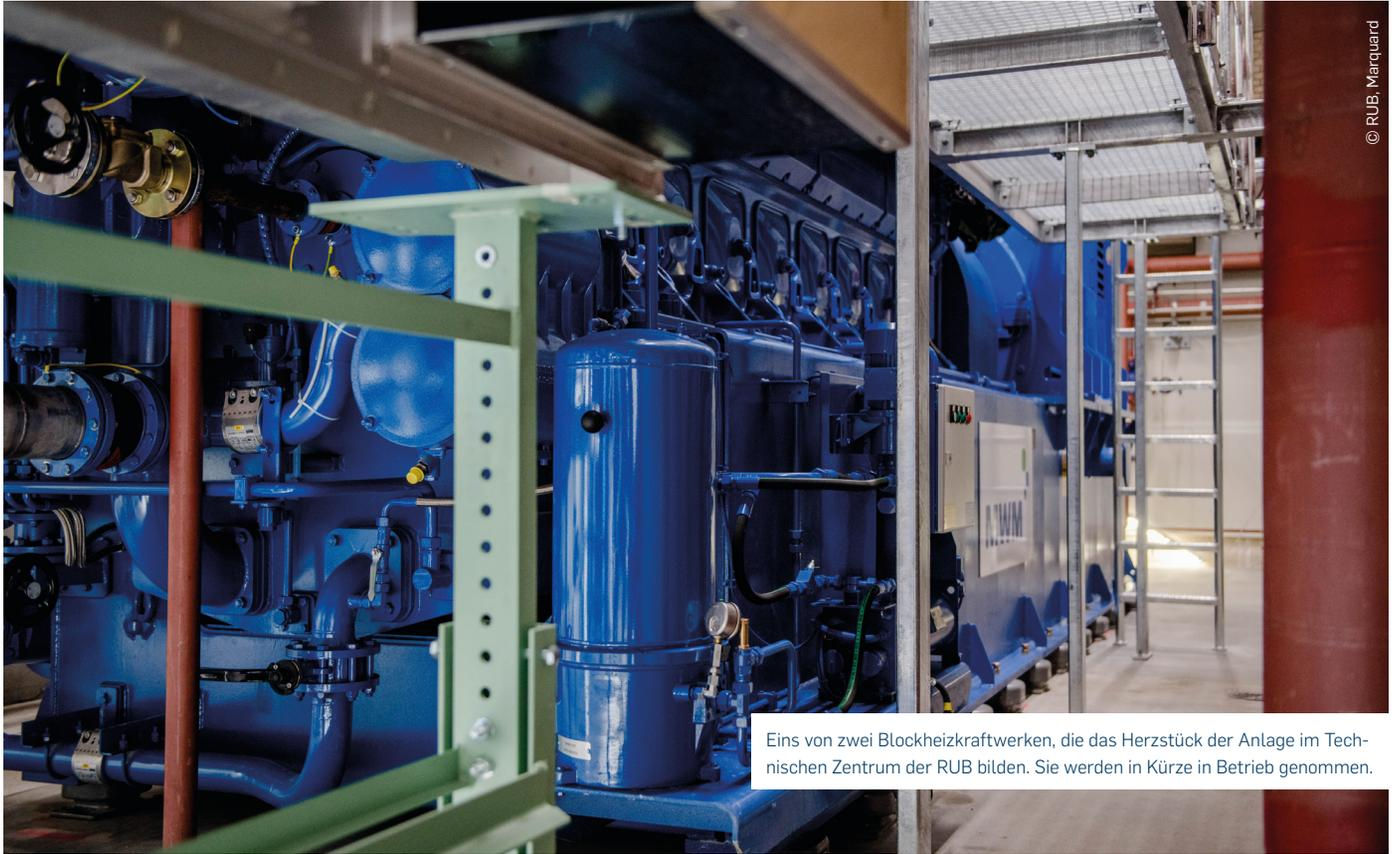
Eins von zwei Blockheizkraftwerken, die das Herzstück der Anlage im Technischen Zentrum der RUB bilden. Sie werden in Kürze in Betrieb genommen.
