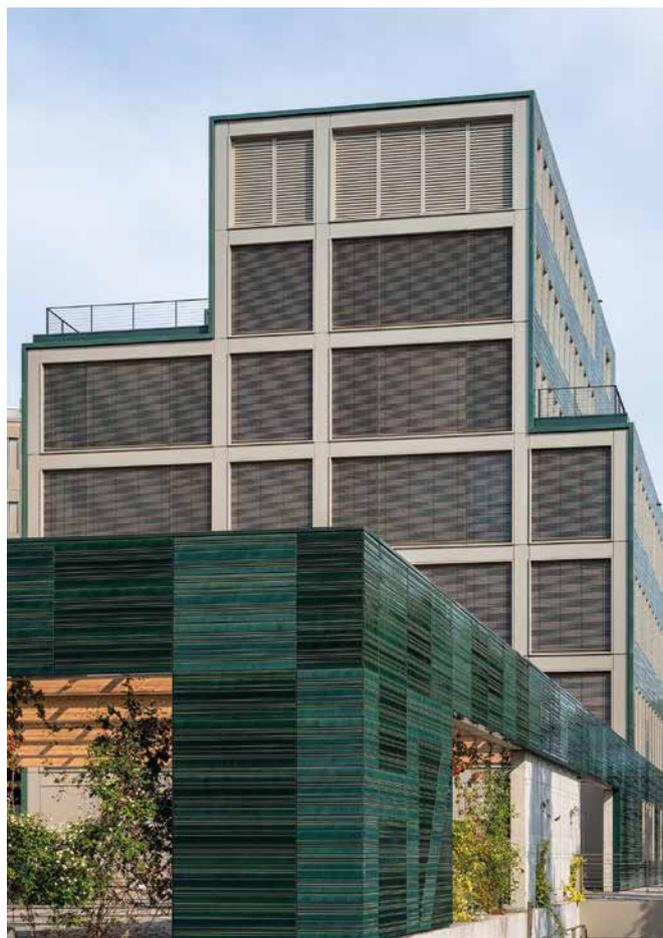
Das „H7“ in Münster ist der erste Hybrid-Holzbau in NRW gewesen. Die tragende Konstruktion besteht zum Teil aus Holz, zum Teil aus Stahl und Stahlbeton.
