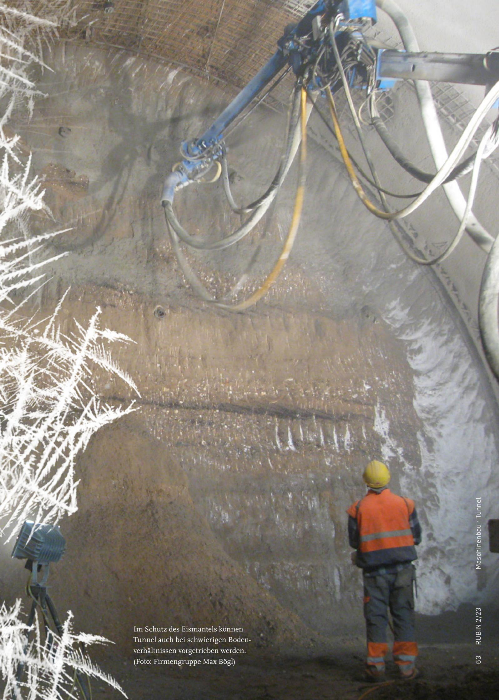
Im Schutz des Eismantels können Tunnel auch bei schwierigen Bodenverhältnissen vorgetrieben werden.
